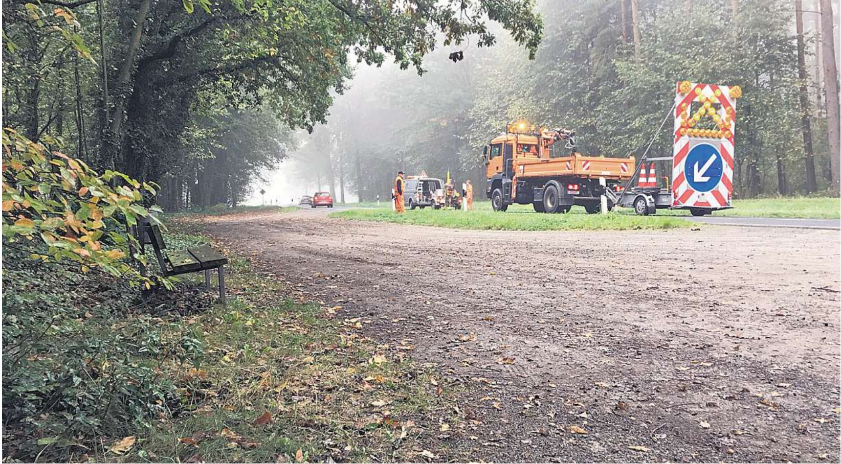
Ein Bautrupps zieht auf der Landstraße 311 zwischen Sorgensen und Dachtmissen Bohrkerne, um für die geplante Sanierung die Beschaffenheit des Untergrunds zu erkunden.
